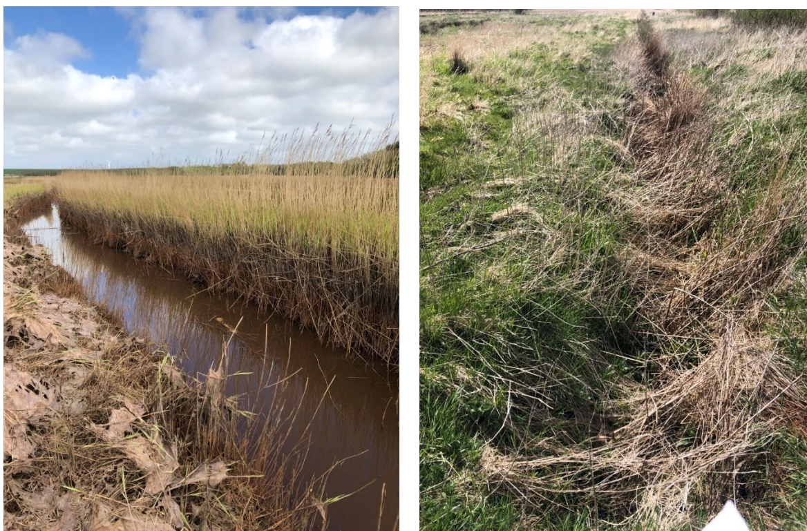
Figur 3-19 Billedeksempler fra Heltborg Pumpekanal. Venstre: Billede fra den nedstrøms del med tydelige tegn på vedligehold. Højre: Billede fra den opstrøms del, hvor vandløbet er helt tilgroet.
