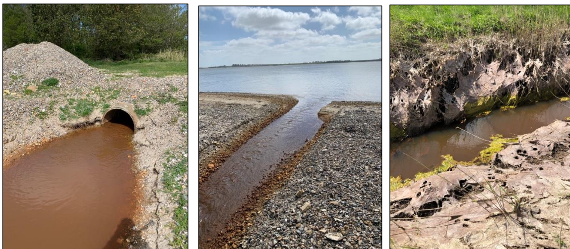
Figur 3-20. Billeder fra udløbet fra Heltborg Pumpekanal med tydelige tegn på okkerudvaskning og slamaflejring på brinkerne.
