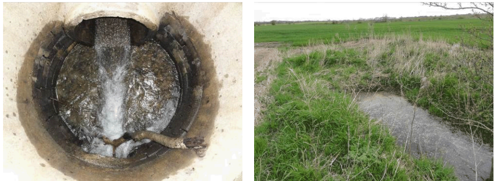
Figur 13 Tv. Brøndene er opbygget i tegl med en betonring øverst. Th. ved rørføringens start opstaves vandløbet.
