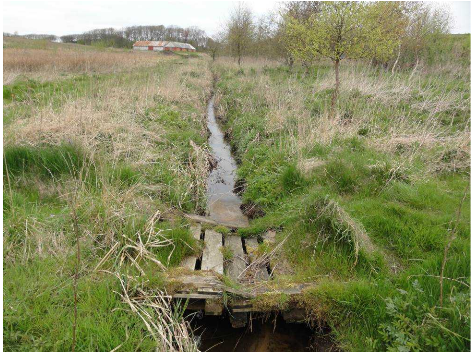
Figur 33 Vandløbet er smalt og kanaliseret, men løber terrænnært og gennem en naturbeskyttet eng.
