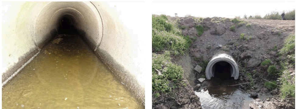
Figur 7 Tv. Begge rørføringer ligger hensigtsmæssigt i forhold til vandløbsbunden. I den nordlige er der grus i dele af røret, mens røret andre steder har glat bund. Th. Den sydlige rørføring er blevet renoveret for nyligt.
