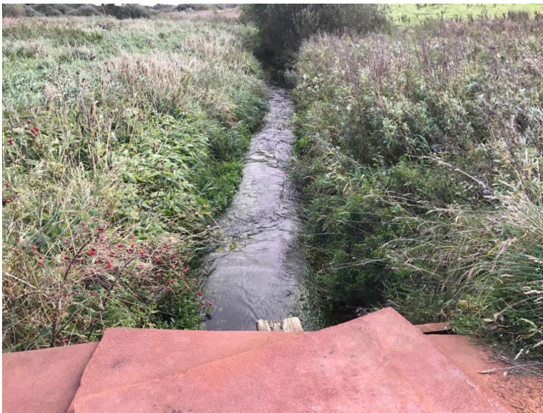
Figur 15: Kort stenstryg nedstrøms overkørsel
