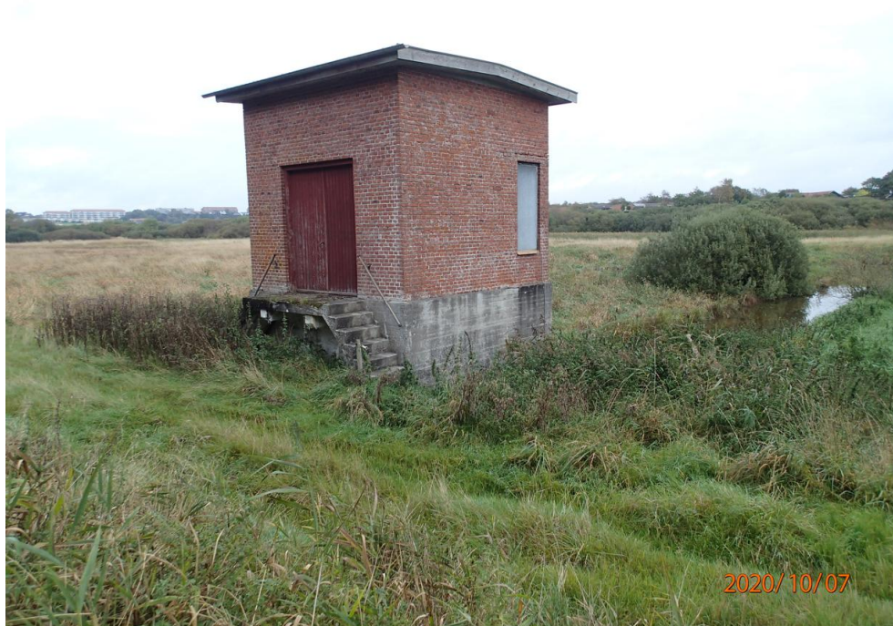
Figur 3-3 Pumpehus, der styrer vandstanden indenfor projektområdet. Foto: Torben Ebbensgaard/COWI.
