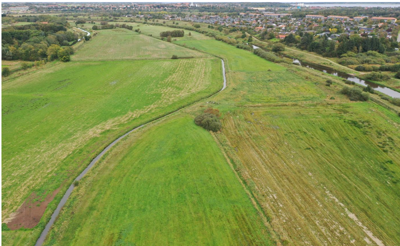
Figur 5-1 Foto mod nord af den nordlige del af projektområdet. Til venstre ses Koholm Å, i midten en stor pumpe-/afvandingskanal og til højre Karup Å.
