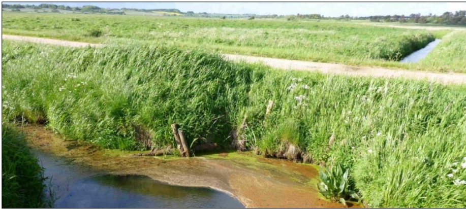
Figur 2-28. Underføring af afvandingskanal beliggende ved grusvejen på tværs af undersøgelsesområdet.
