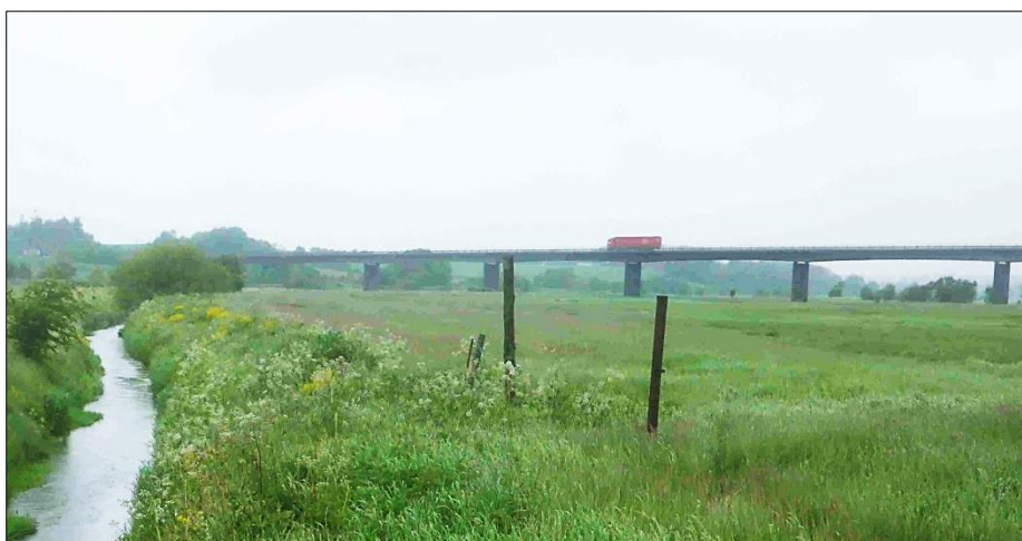
Figur 2-27. Ringvej Syd krydser undersøgelsesområdet via en højbro.
