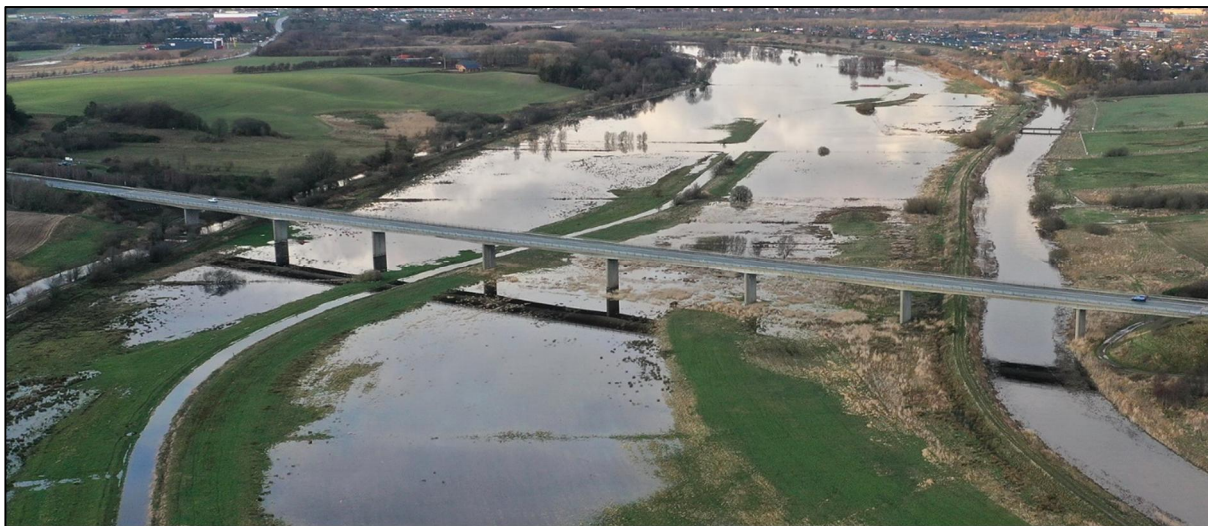
Figur 3-3 Dronefoto af oversvømmelser ved digebrud d. 3. marts 2020 (Kilde: Poul Gravgaard, Formand for pumpelaget).
