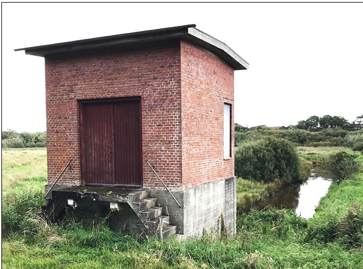
Figur 3-23 Pumpestationen der styrer vandstanden i pumpelaget.
