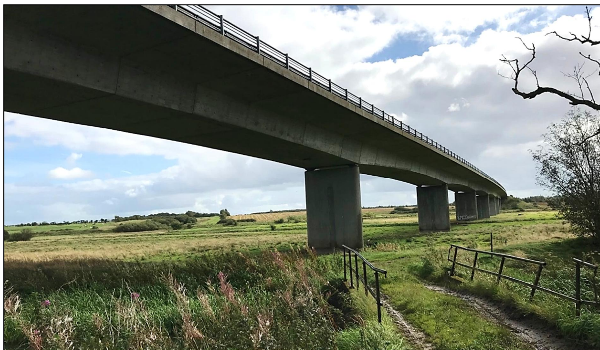
Figur 3-22 Ringvejsbroen set fra vest mod øst.
