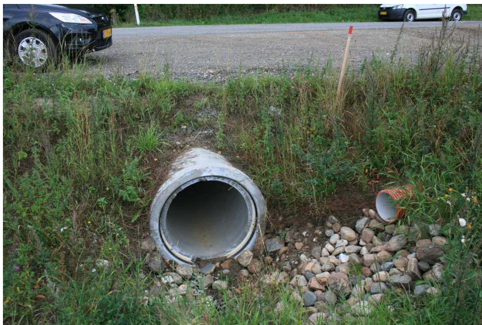
Figur 18 Udløbet af regnvandsledning under Viumvej. Tophøj Bæk løber formentligt i et Ø500 rør ca. 0,5 m under regnvandsledningen og gennem en brønd, der ikke ses på billedet, men er lige nedenfor udløbet. Tilkørslen til vindmøllerne er til højre i billedet. Viumvejs overflade ligger ifølge terrænmodellen her i kote 14,25 m. Vandløbets bund er ikke opmålt, men skønnes til ca. 12,25 m.
