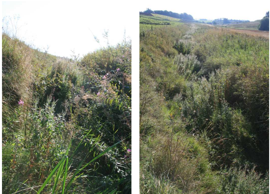
Figur 8 På denne strækning ligger Otting Bæk ca. 2 m under terræn
