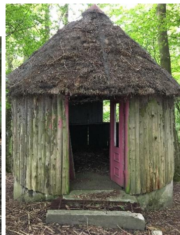
Tv. Resterne af et gammelt betonstemmeværk. Th. Lysthus på betonringe.
