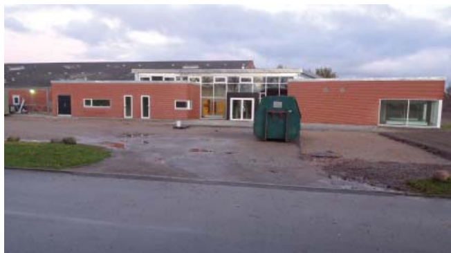
Fursund hallen under ombygning.
