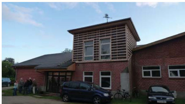
Galleri da Winti under ombygning.
