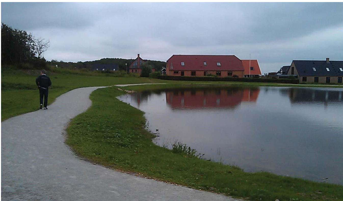
Entreprenørarbejdet er færdigt i Gyldendal. Næste etape er etablering af shelters, bålpladser, mv.
