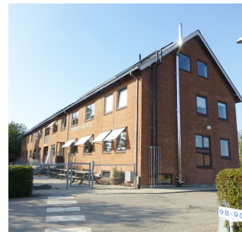
Det tidligere Jebjerg Børnehus på Østergade 9
