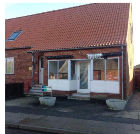
Ørslevklostervej 142 opkøbt til Hald Borgerforening med planer om nedrivning
