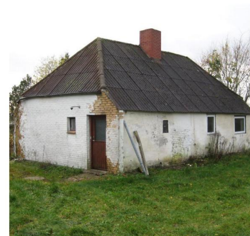
Tidl. Fælledvej 20, Hald - nedrevet med midler fra Landsbypuljen
