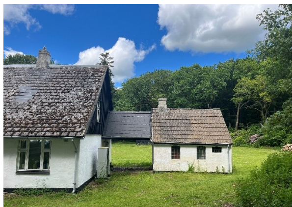
Figur 6 Den lille overdækning og tilbygning øst for stuehuset
