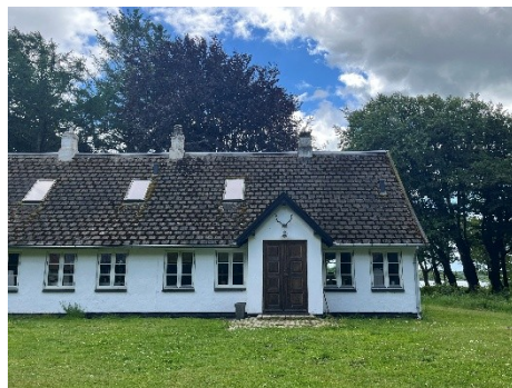
Figur 4 Foto set fra gårdspladsen af indgangspartiet
