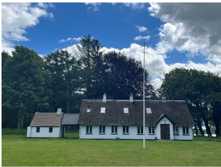
Figur 9 Stuehusets nordvendte facade
