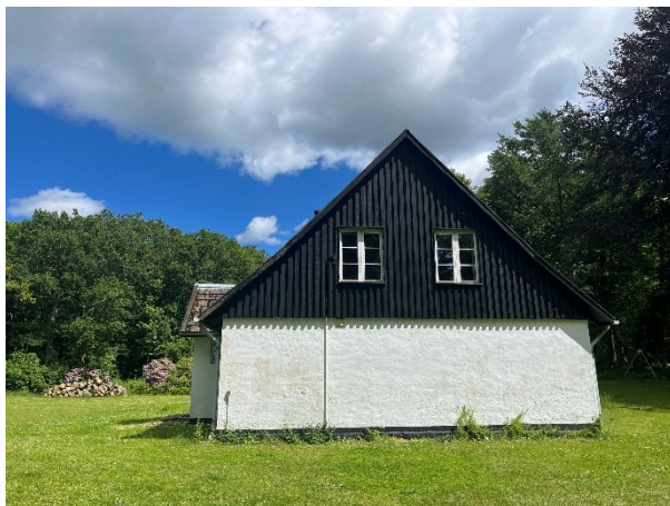
Figur 8 Stuehusets vestvendte gavl
