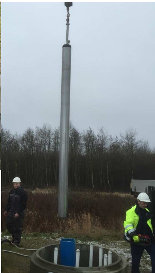
Figur 4.8.2. Fryseelement bliver nedsænket i boring
