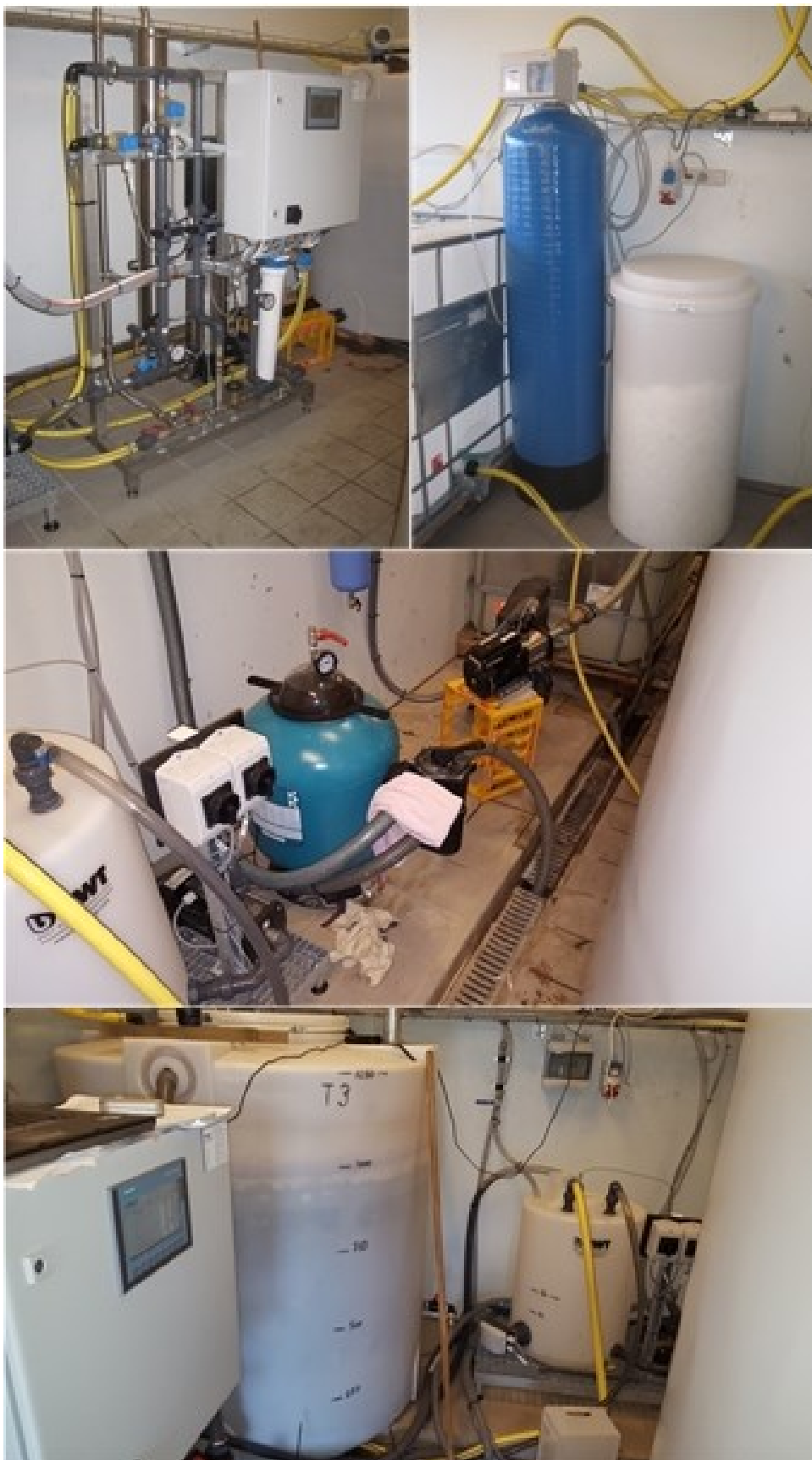
Figur 2: Billeder fra pilotanlægget i Odense. Øverst til venstre: NF-anlægget. Øverst til højre: Ionbytter. Midt: Sandfilter. Nederst: Koncentrattanken T3.
