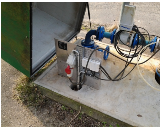
Foto nr. 14. Afværgeboring AFV1
