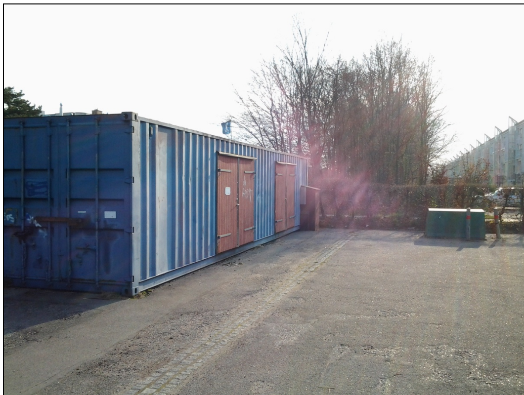
Afværgeanlæg Kirke Værløsevej 53
