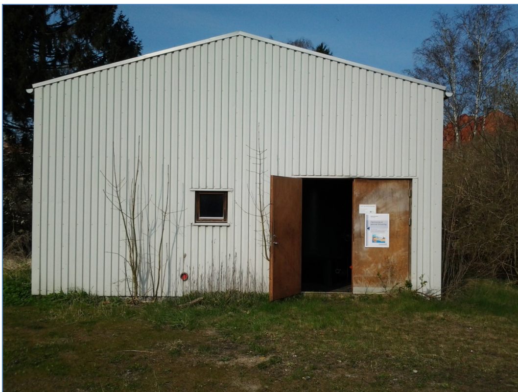
Afværgeanlæg Søborg Hovedgade 31
