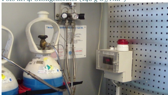
Foto nr. 5. Iltflasker til produktion af ozon
