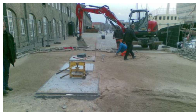
HydroSeparator® under etablering på Holmen, København
